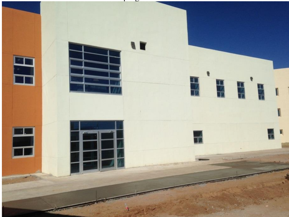
Edificio De en DMNCG
