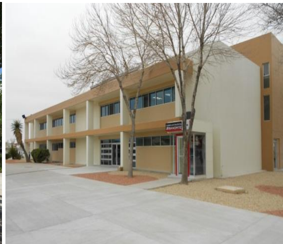
Edificio C del ICB
