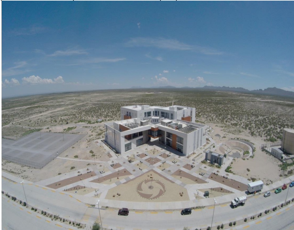
Edificio CUIPE en la DMCU
