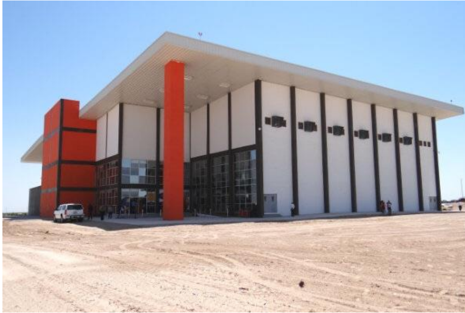
Gimnasio de Usos Múltiples DMCU
